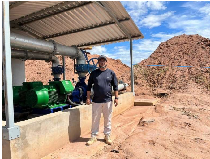
Manutenção adutora, casa de bombas nº 01 Fazenda Rio Grande
